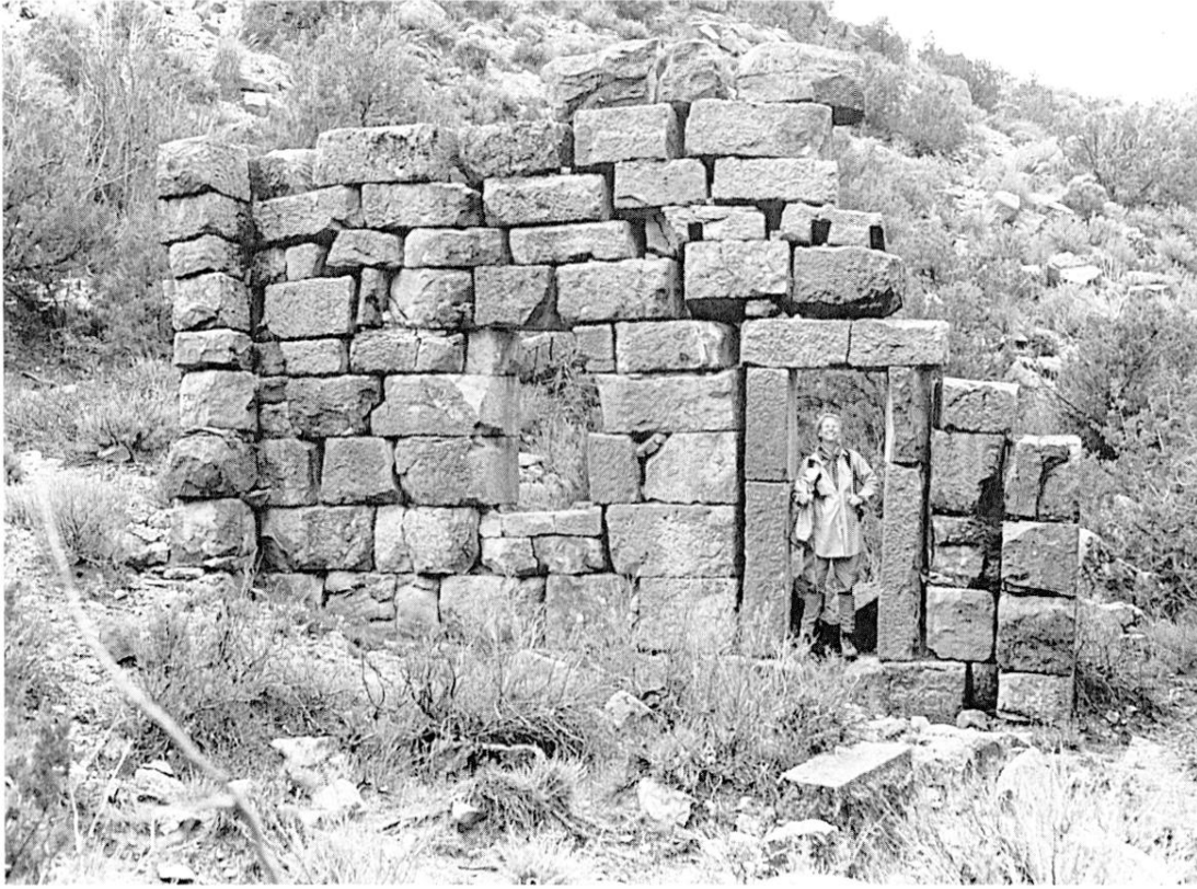
FIG. 43. — Ksar Roumia 1, mur sud de l'intérieur de l'huilerie. De gauche à droite, fenêtre et « porte » dont les montants sont en réalité les montants du pressoir entre lesquels s'insère le levier.
