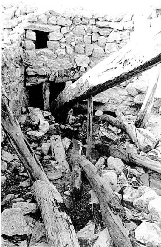
FIG. 53. — Moulin du type « Masqueray » en son état actuel au hameau de Tizi. La pièce où se trouve le levier s'appuie sur le rocher. Elle a 6,10 m × 5 m. À gauche : le levier (L. : 4,38 m), fixé par un axe entre deux jumelles en bois, est maintenu en position haute par une béquille ; à droite : dans la pièce attenante, ce qui reste de la mola olearia (comparer avec la fig. 52) (cl. J. Mermet).
