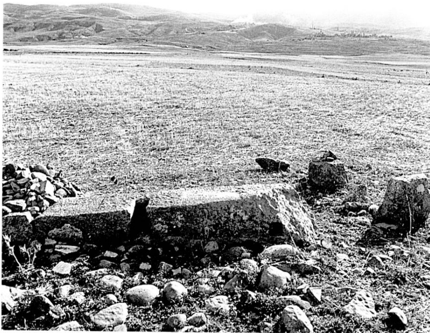
FIG. 28. — Mechgoug est, bloc d'assise. On devine les traces, à peine visibles, des jumelles, de part et d'autre de la mortaise en queue d'aronde (cl. J. Mermet).
