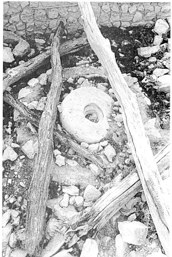
FIG. 53. — Moulin du type « Masqueray » en son état actuel au hameau de Tizi. La pièce où se trouve le levier s'appuie sur le rocher. Elle a 6,10 m × 5 m. À gauche : le levier (L. : 4,38 m), fixé par un axe entre deux jumelles en bois, est maintenu en position haute par une béquille ; à droite : dans la pièce attenante, ce qui reste de la mola olearia (comparer avec la fig. 52) (cl. J. Mermet).
