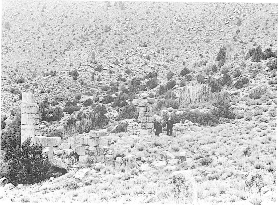
FIG. 46. — Ksar Roumia 2, vue générale prise du côté nord. L'angle nord-ouest est recouvert par la végétation.
